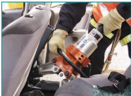
Установить один из рабочих наконечников расширителя в основание задних кресел автомобиля. Медленно и осторожно раскрывать его, следя за устойчивостью точки опоры, после чего опереть другой рабочий наконечник в нижней части средней стойки В. Теперь необходимо отжать стойку наружу, отводя ее от порога автомобиля.
