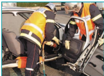
Снять переднюю дверь автомобиля с петель, в то время как другие спасатели поддерживают дверь от падения.
