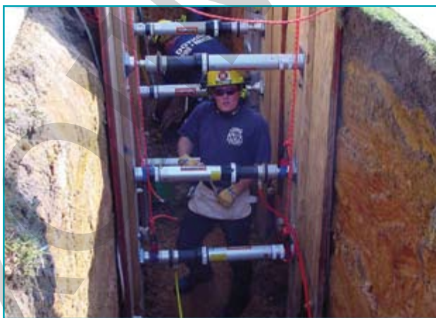
Правильно закреплённая траншея
