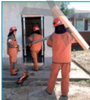
Такая крепь должна быть сначала собрана в безопасной зоне и потом устанавливается в требуемом месте. Обычно её используют с брусом сверху и снизу для равномерного распределения нагрузки. В зависимости от типа покрытия бывает удобнее применить наклоняемые опоры в основании крепи.
