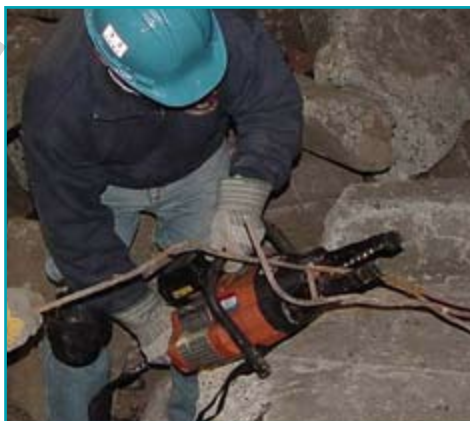
Использование аккумуляторного комбининструмента для резки
