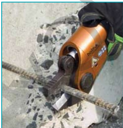
Мини-резак перекусывает арматуру
