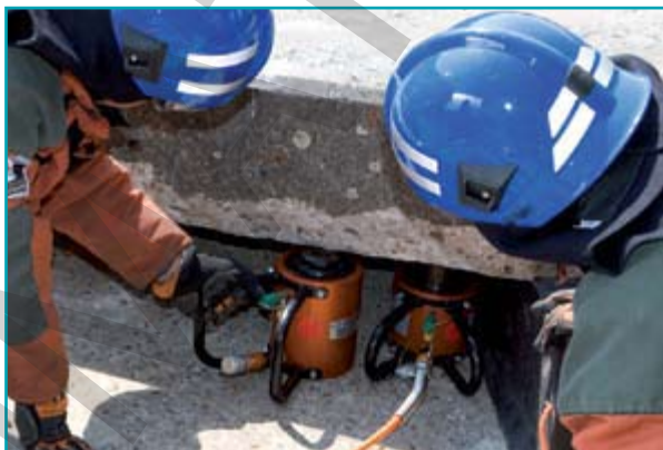
Два домкрата разных размеров используются для постепенного подъёма
