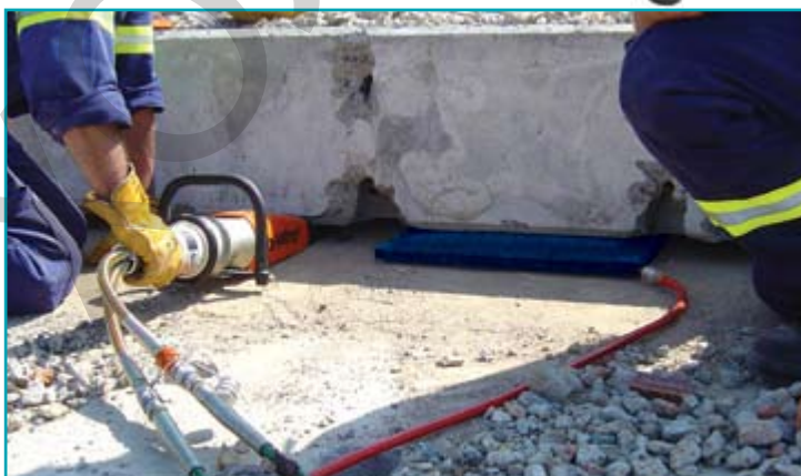
Использование подушки в небольшом проёме, созданном гидроклином
