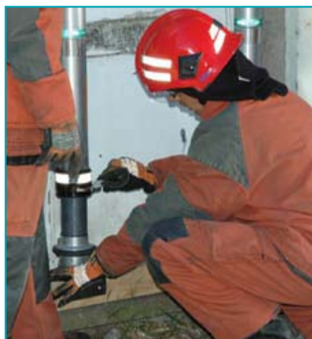
Установка ручной распорки в дверном проёме
