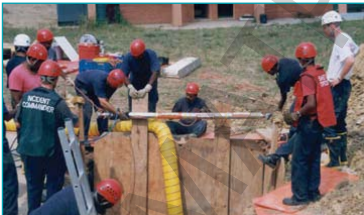
Дистанционное управление распоркой при операции на провале
