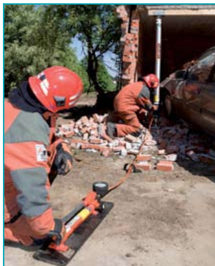
Гидравлическая распорка осторожно используется для фиксации
