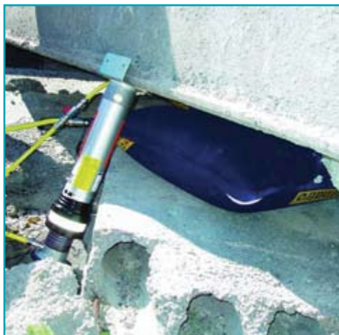
Страховая распорка , использованная при работе подъёмной подушки
