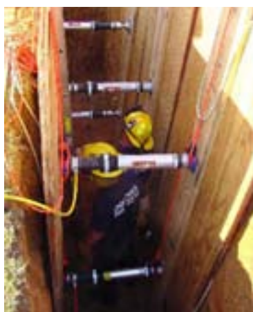
Закрепление провала пневматической распоркой с фиксатором.
