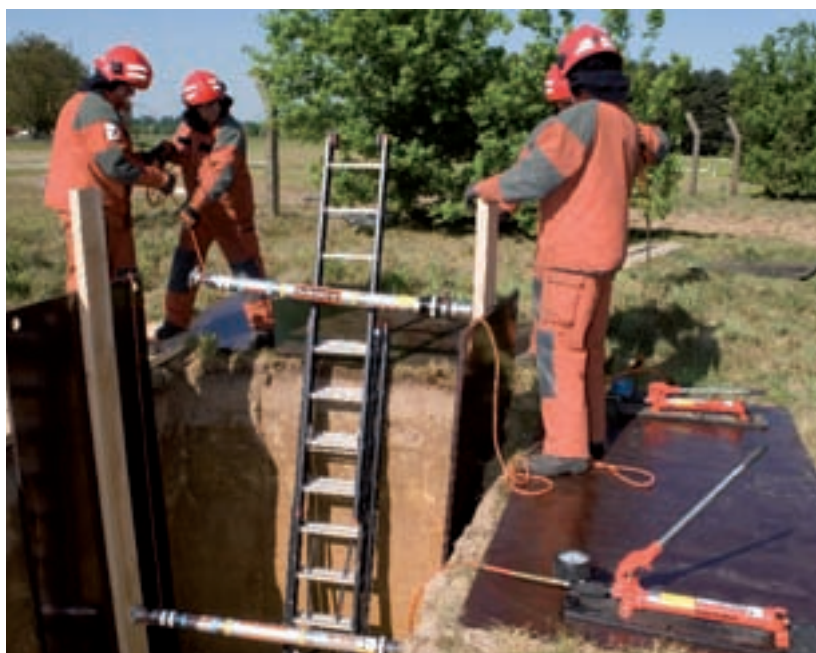
Удалённое крепление при помощи гидравлических распорок с автоматическим фиксатором.
