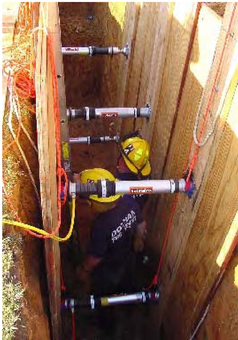
Закрепление траншеи при помощи пневматической распорки с автоматическим фиксатором.
