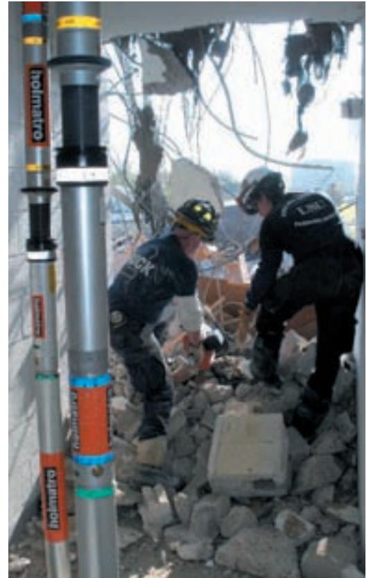
Стабилизация обрушенного здания при помощи ручной распорки с контргайкой.
