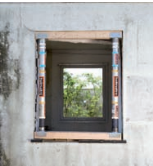
Ручные распорки с удлинителями, балочными упорами и балкой, установленные для стабилизации окна.
