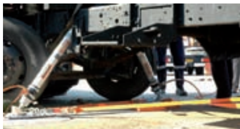
Стабилизация грузового автомобиля гидравлической распоркой с контрражкой.
