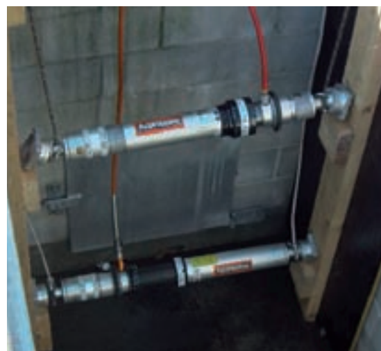
Удалённое крепление при помощи распорок с автоматическим фиксатором.
