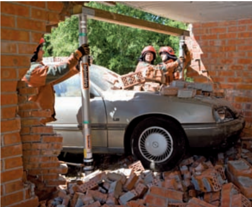
Установка двух распорок с балочными упорами и балкой для стабилизации строения. Гидравлические распорки с контргайкой осторожно раздвигаются при помощи ручного насоса.
