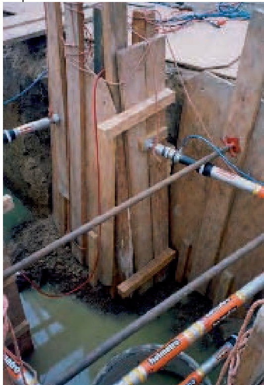
Пневматические распорки с автоматическим фиксатором, установленные в провале.
