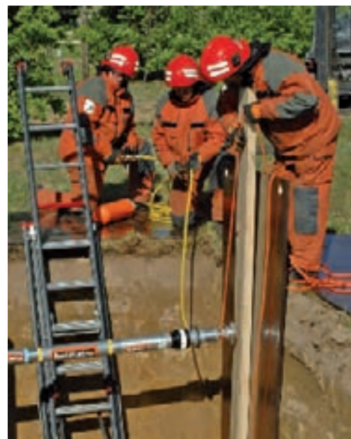
Пневматическая распорка с автоматическим фиксатором применяется для удалённого закрепления при спасении из провалов.
