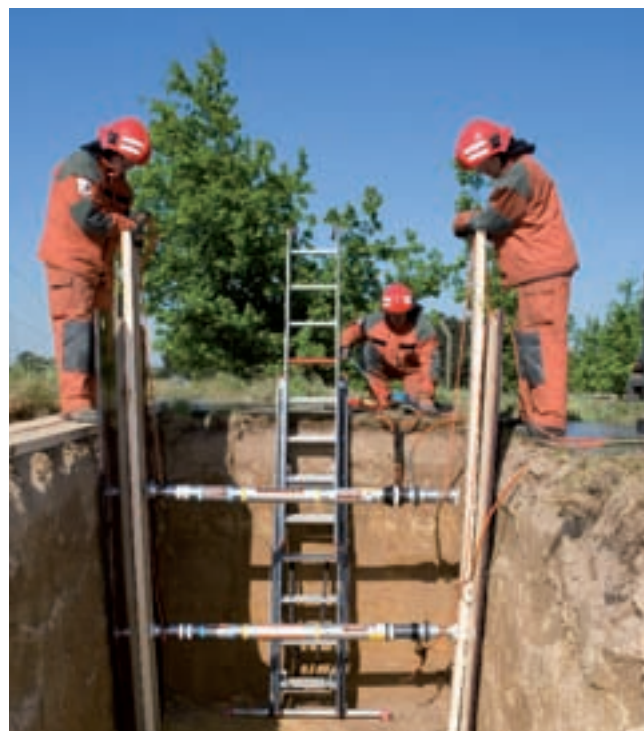
Дистанционное закрепление гидравлическими распорками с автоматическим фиксатором.
