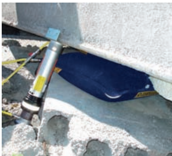
Распорка с автоматическим фиксатором поддерживает подъёмную подушку.
