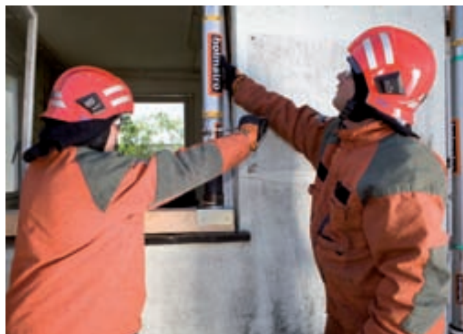
Использование ручной резьбовой распорки для закрепления окна. Её можно фиксировать при помощи ключа для круглых шлицевых гаек (на фотографии ниже).
