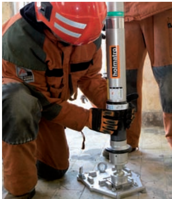
Пневматическая распорка с контргайкой используется как ручная опора для закрепления здания.
