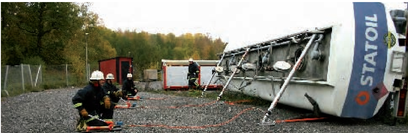
Закрепление и подъем тяжелого грузовика гидравлическими крепами PowerShore™.
